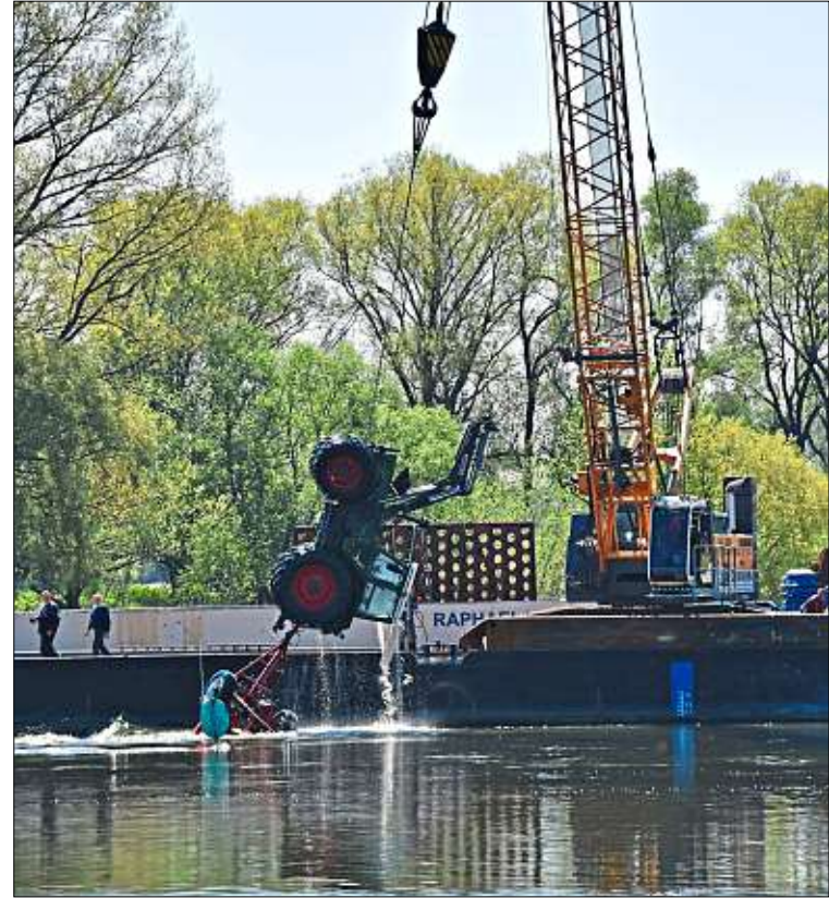
Den Bulldog am Haken hatte der Kran bei der Bergung nach dem Untergang der Fähre. – Fotos: Archiv/Hahne
